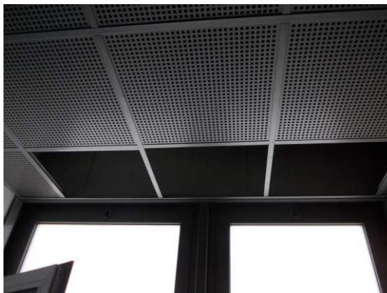
FIG. 2.4 Bagni femminili:controsoffittatura priva di pannelli
