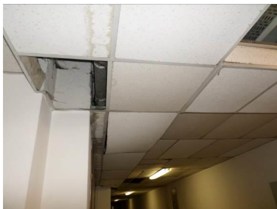
FIG. 4.8 Corridoio: controsoffittatura priva di pannelli
