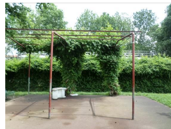
FIG. 6.5 Pilastri privi di protezioni antiurto
