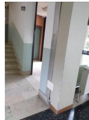
FIG. 6.6 Muratura e scossalina degradati
