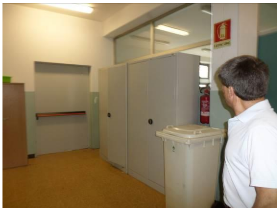
FIG. 1.5 Estintore difficilmente accessibile
