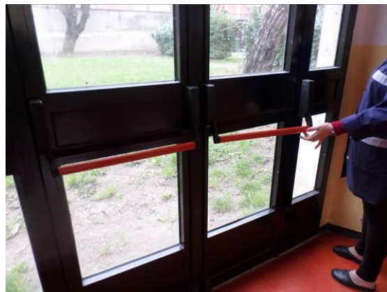
FIG. 5.7 Palestra: maniglione danneggiato
