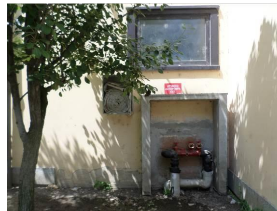
FIG. 6.7 Attacco autopompa e idrante danneggiati
