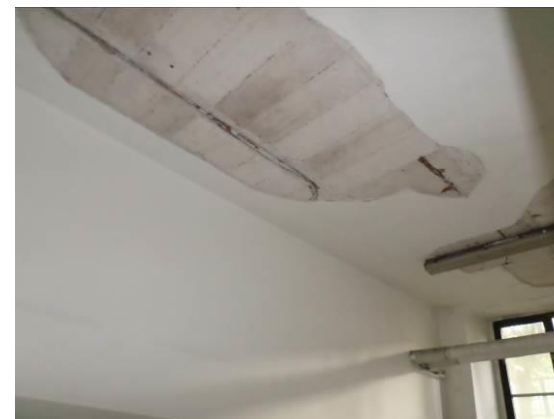
FIG. 6.8 Distacco d'intonaco
