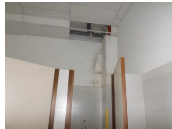
FIG. 6.3 Bagni: controsoffittatura danneggiata
