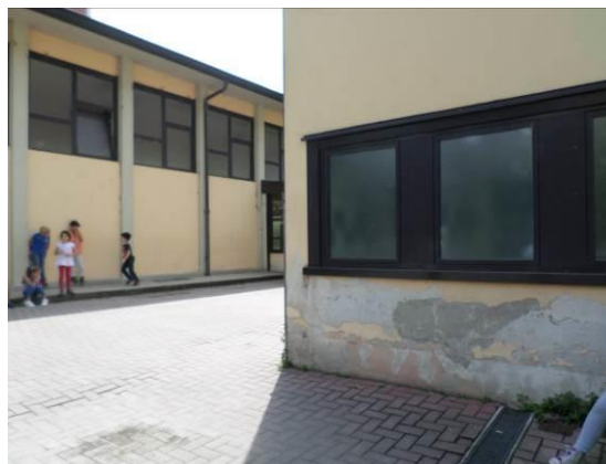
FIG. 5.7 Muratura esterna degradata
