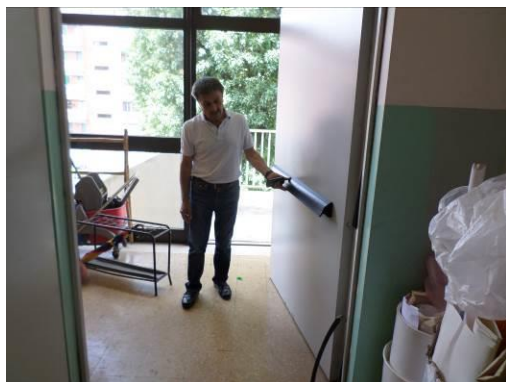
FIG. 1.4 Uscita di emergenza: materiale di risulta
