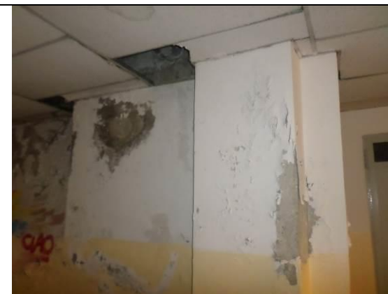
FIG. 3.8 Corridoio: tracce di infiltrazioni
