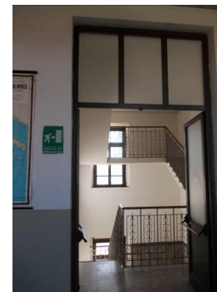
FIG. 3.4 Corridoio: uscita di emergenza segnalata in modo errato
