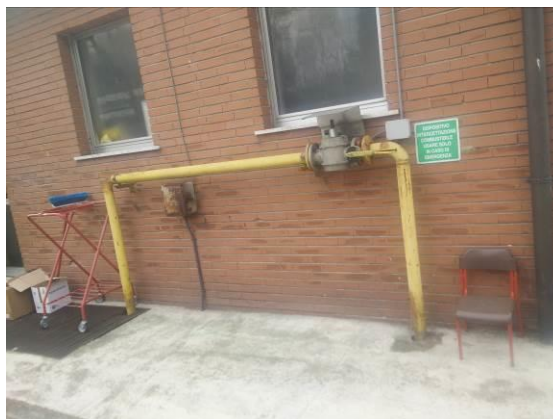
FIG. 2.5 Dispositivo intercettazione combustibile
