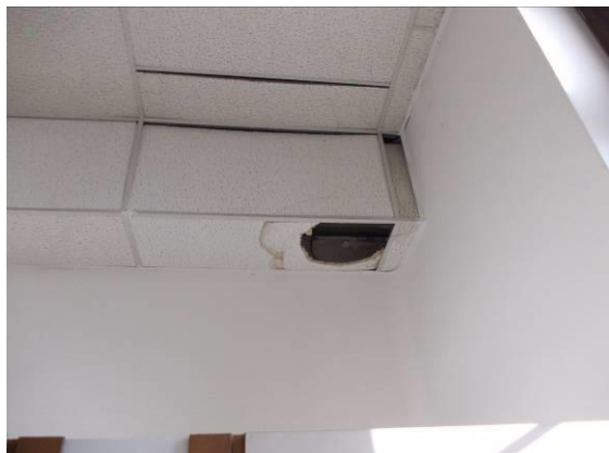
FIG. 7.3 Bagni: controsoffittatura danneggiata
