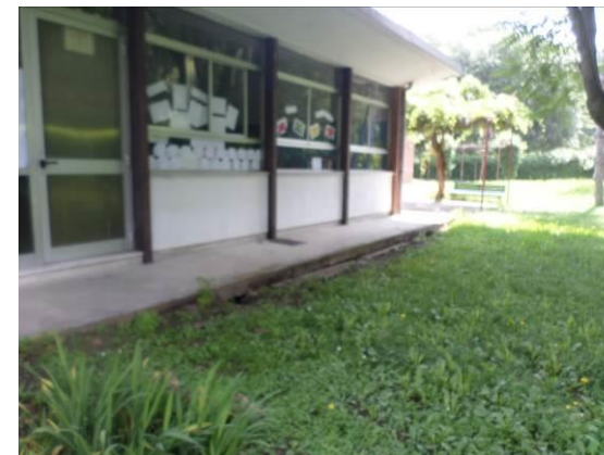
FIG. 2.5 Scollamento tra gradino e terreno
