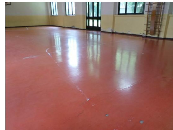
FIG. 3.7 Palestra: pavimentazione danneggiata
