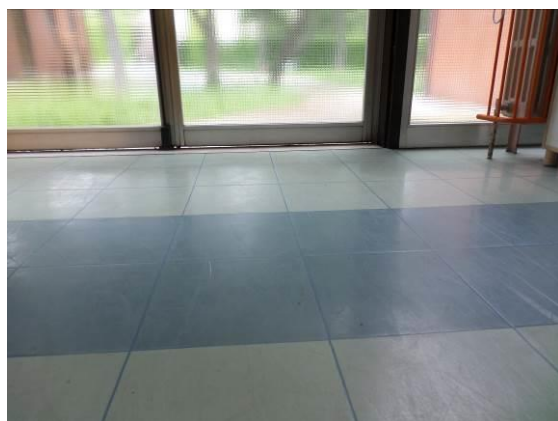
Fig. 4.3 Pavimentazione in linoleum
