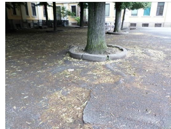
FIG. 9.7 Cortile: pavimentazione disastata
