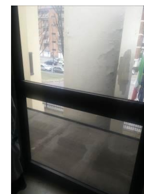
FIG. 6.4 Infiltrazioni e distacchi intonaco
