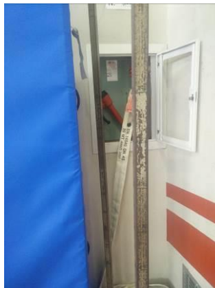
FIG. 2.6 Idrante difficilmente accessibile e non avvolto correttamente
