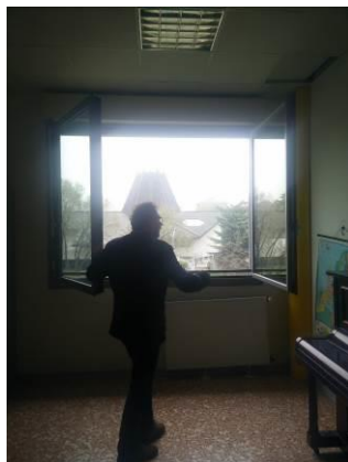
FI. 1.3 Finestre con spigoli vivi privi di paraspigoli
