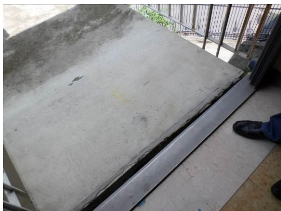
FIG. 4.4 Distacco/fessurazione esistente tra il pianerottolo della scala esterna d'emergenza e solaio dell'edificio
