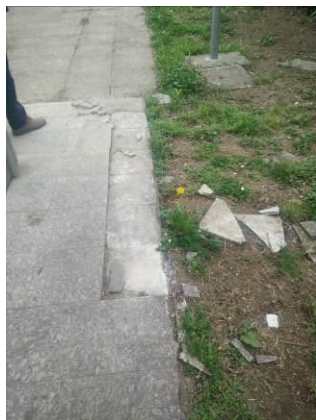
FIG. 1.7 Pavimentazione dissestata
