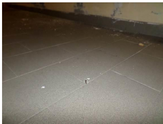
FIG. 5.8 Chiodo sporgente dalla pavimentazione
