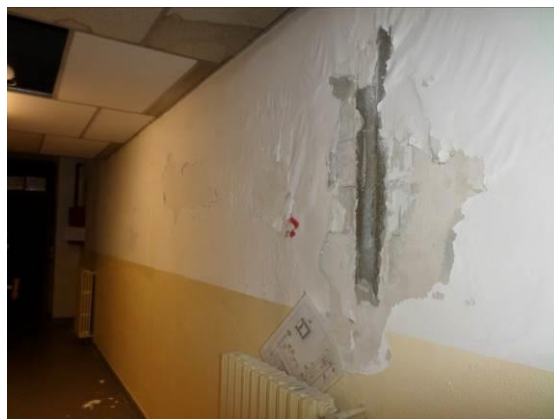
FIG. 2.8 Corridoio: tracce di infiltrazioni
