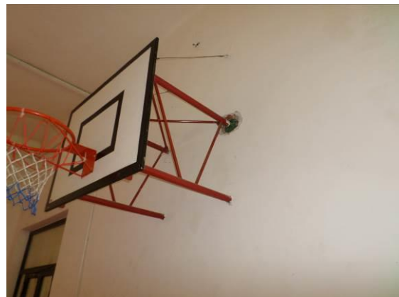
FIG. 4.7 Palestra: sostegno canestro basket con muratura forata
