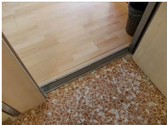
FIG. 1.4 Aula musica:dislivello nella pavimentazione
