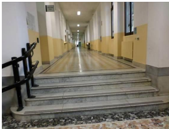
FIG. 8.7 Corridoio: scala priva di un corrimano
