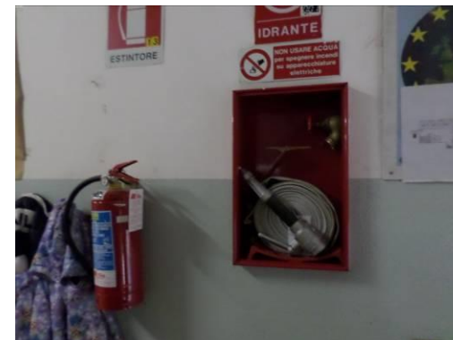
FIG. 3.4 Idrante privo della lastra safe crash
