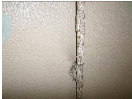
FIG. 5.4 Tubazioni in cattivo stato
