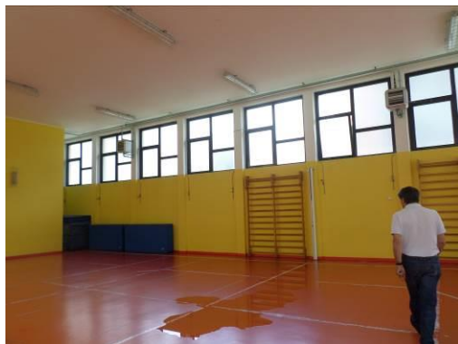
FIG. 1.6 Palestra: infiltrazioni d'acqua
