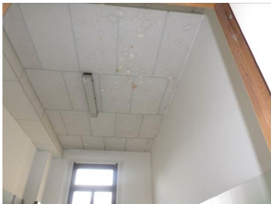
FIG. 1.5 Bagno maschile: controsoffitto con segni di infiltrazioni e pallottole carta attaccate
