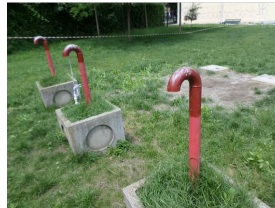
FIG. 3.7 Tubazioni verticali delle uscite antincendio accessibili
