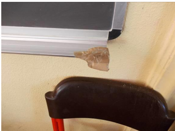
FIG. 4.3 Aule: lavagne con porta gessi con protezioni mancanti o danneggiate
