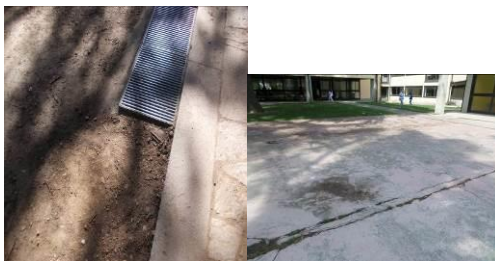
FIG. 1.7 Cortile: griglie sporgenti e pavimentazione degradata
