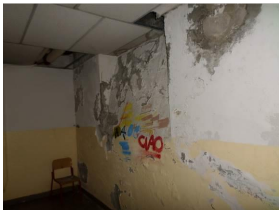
FIG. 1.8 Corridoio: tracce di infiltrazioni
