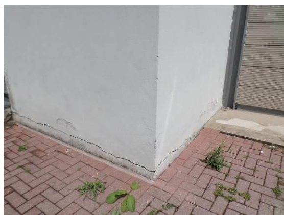
FIG. 4.7 Fessurazione
