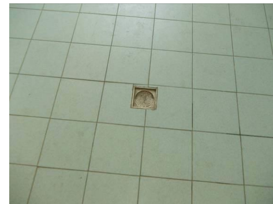
FIG. 6.3 Bagni: griglia di protezione mancante
