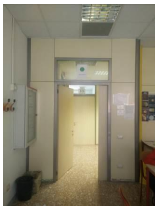
FIG. 4.3 Quadro elettrico non segnalato
