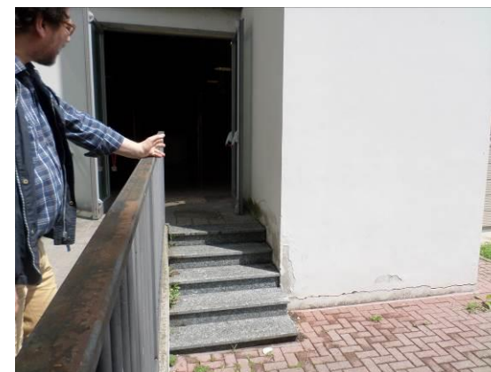
FIG. 3.7 Fessurazione e scala priva di corrimano
