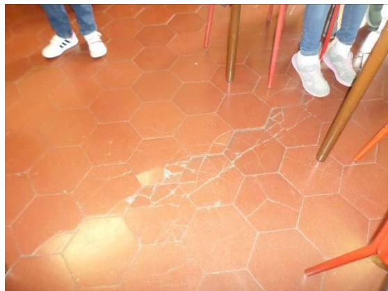
FIG. 1.3 Piastrelle pavimentazione danneggiate
