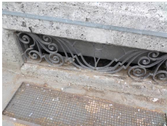
FIG. 8.8 Grate bocche di lupo degradate
